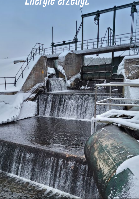
Wasserkraftwerk bei Intersurgical in Litauen
