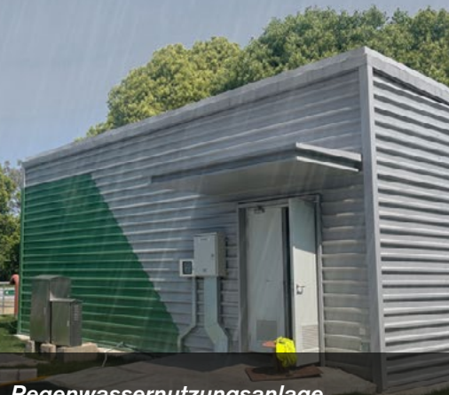
Regenwassernutzungsanlage bei Intersurgical in China
